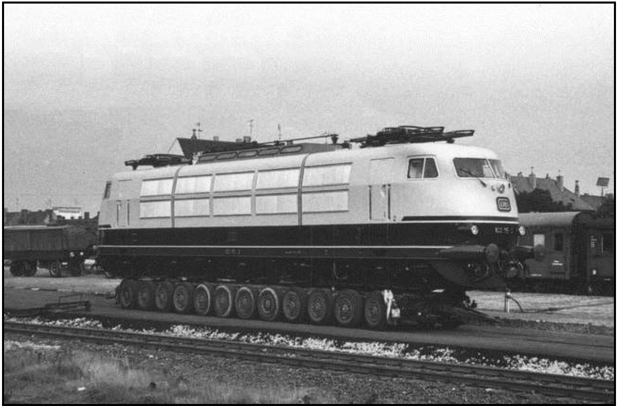
...oder die E 03 (ca. 112 Tonnen) mit zwölfachsigem (!) Culemeyer-Straßenroller in Essen (September 1970)
