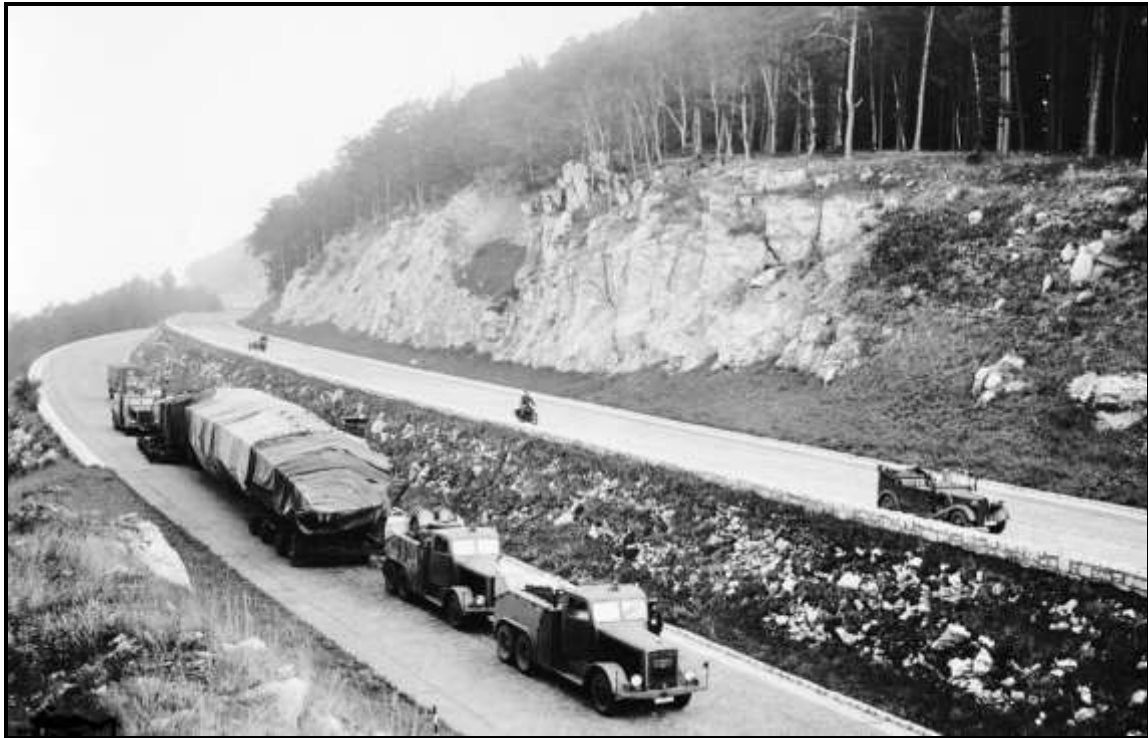
U-Boot-Transport von der Ostsee zum Schwarzen Meer mit mehreren Kaelble Z6 R2A 100 und Culemeyer am Kindinger Berg (1941 - 1942)
