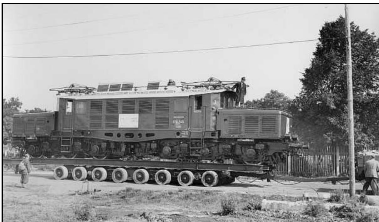
Aber auch schwere Lokomotiven wie die E 94 145 (ca. 120 Tonnen) konnten transportiert werden (1950)
