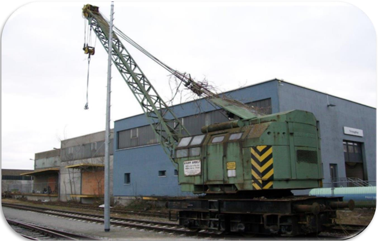
Ein letztes Bild vom Kran vor dem Zerlegen
